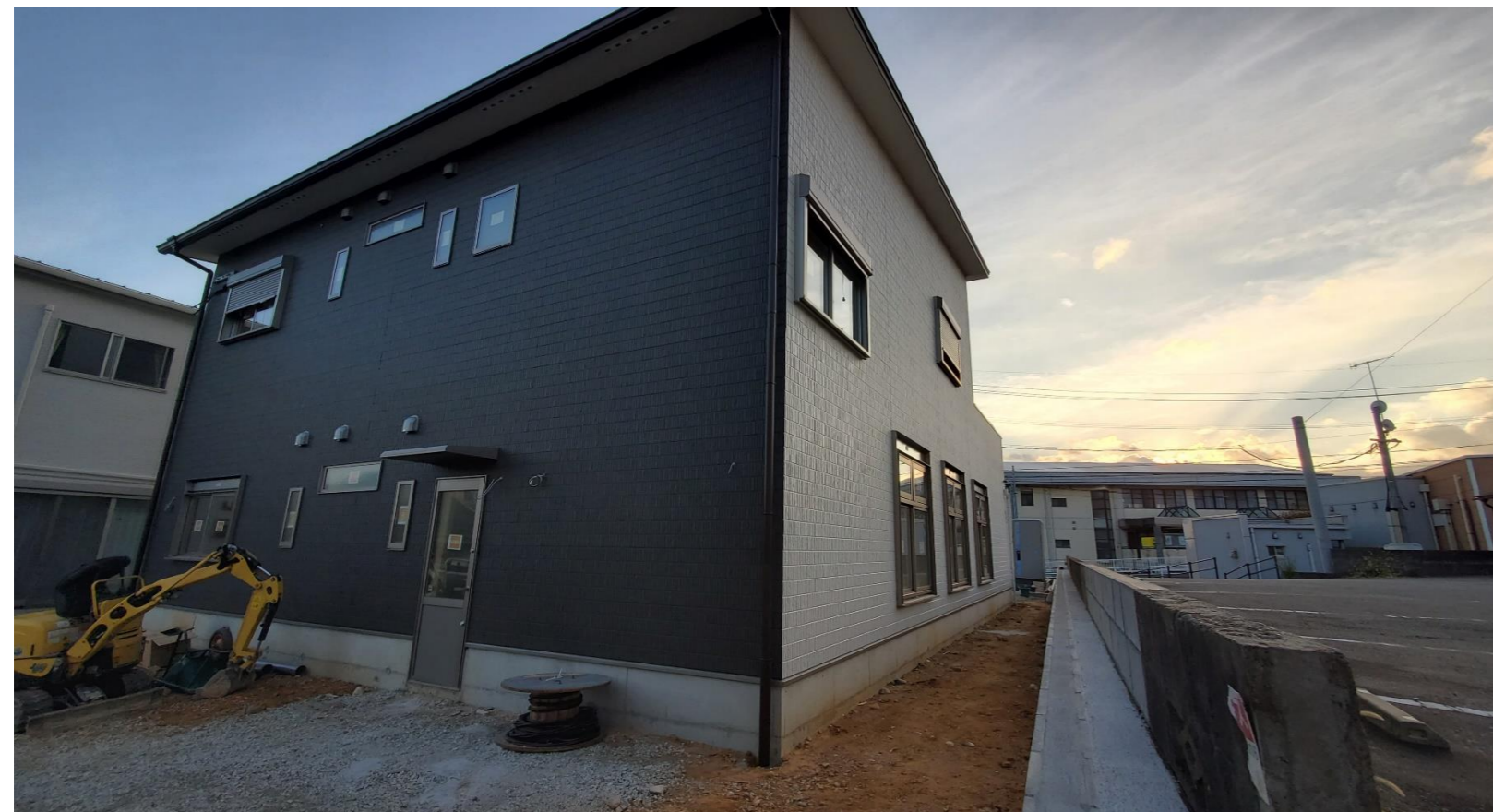
西側からの新会館 右側の福田眼科駐車場との段差ブロック5枚分低くなっています。
